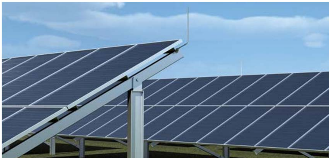
Slika 9. Prikaz montaže loveće palice na metalnu konstrukciju
